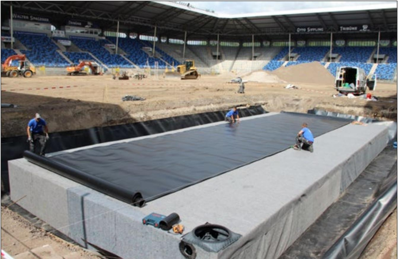
Der Behälteraufbau vor Ort bietet die Möglichkeit Länge, Breite und Höhe der eingeschweißten Rigolen objektspezifisch zu wählen. Insbesondere bei
