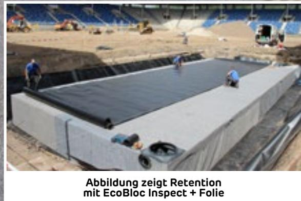
Abbildung zeigt Retention mit EcoBloc Inspect + Folie
