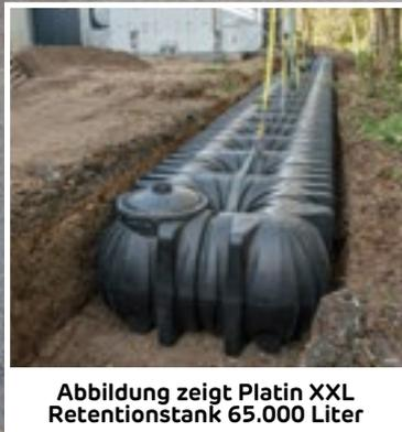
Abbildung zeigt Platin XXL Retentionstank 65.000 Liter
