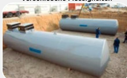
Doppelwandige Tanks für Benzin, Diesel und Heizöl
