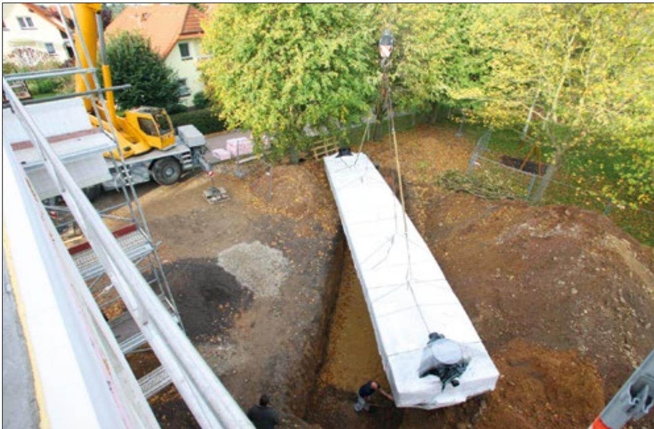
Werkseitig können eingeschweißte Rigolen bis zu einem Volumen von maximal 60 m<sup>3</sup> produziert werden und per Lkw zum Einsatzort trans-
