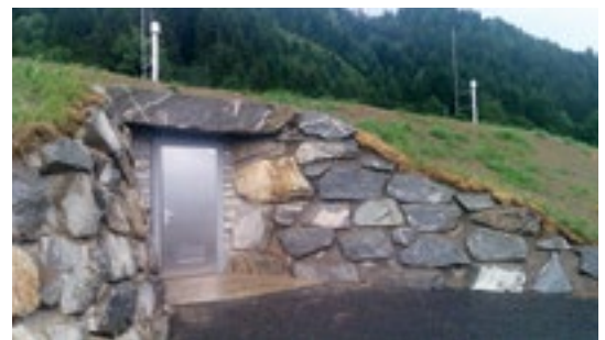
Zugangsbereich mit Steinschichtung
