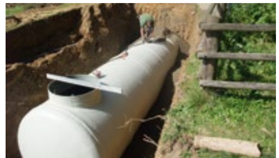
Einbau Trinkwasserspeicher
